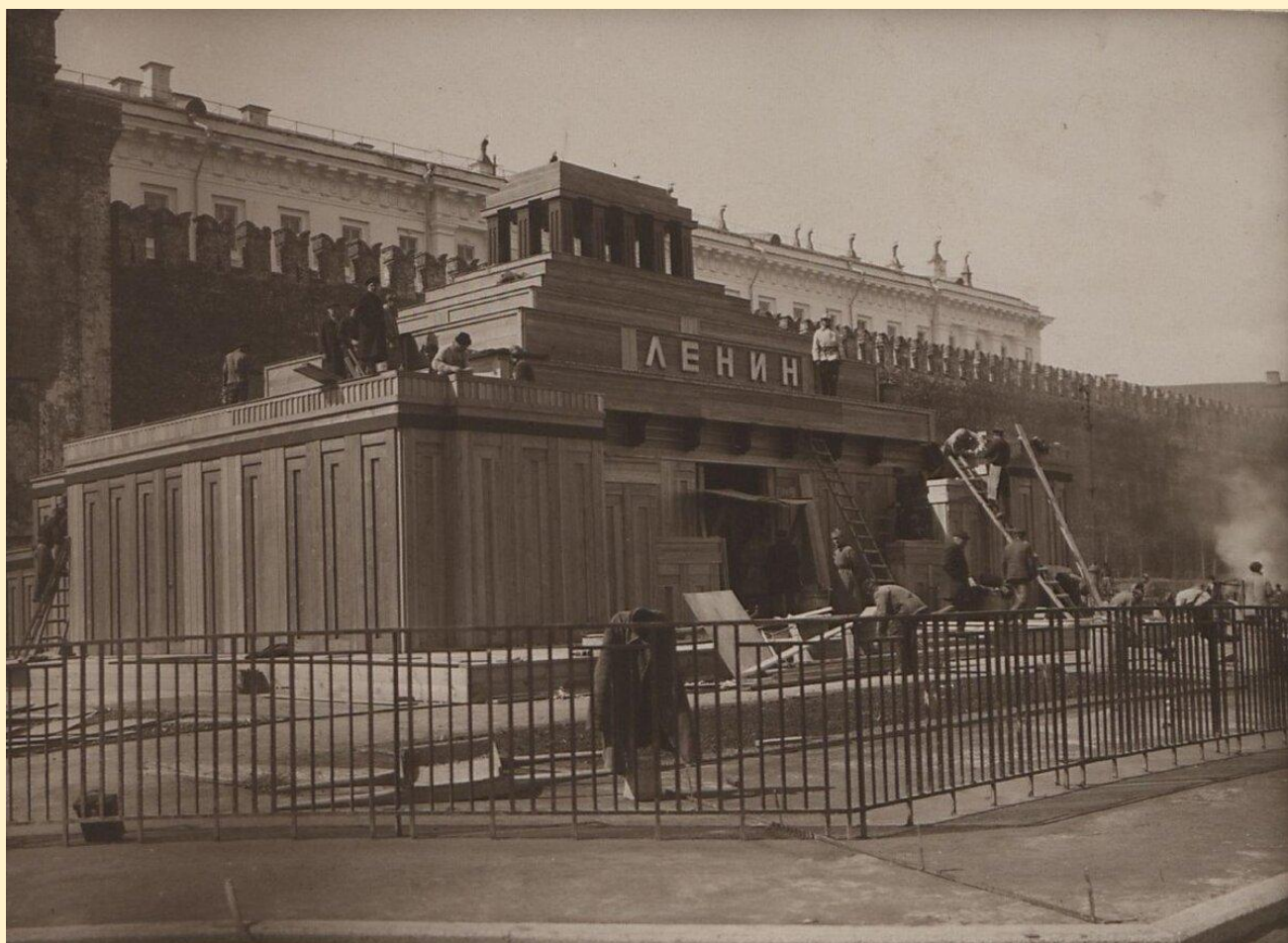
Работы по возведению 2-го деревянного мавзолея.
